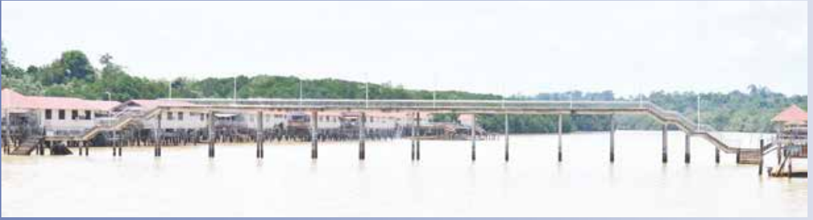
JAMBATAN yang menghubungkan penduduk Kampung Bolkiah 'A' dan 'B'.
