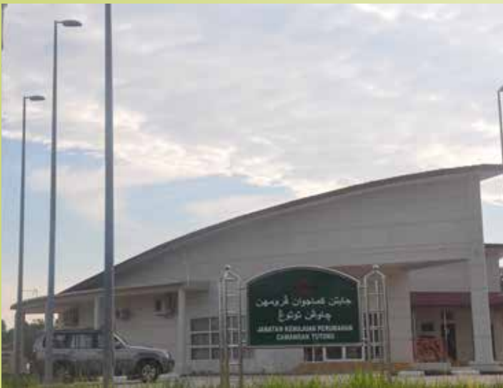
BANGUNAN Jabatan Kemajuan Perumahan, Cawangan Tutong.
